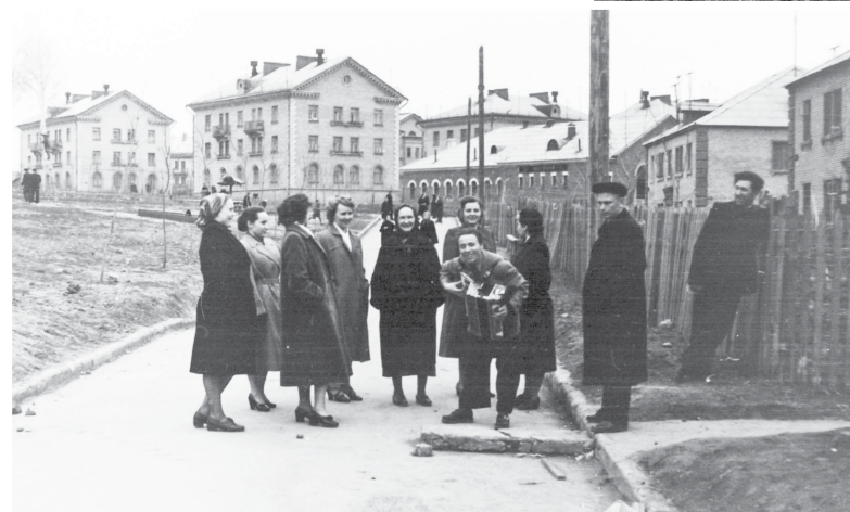
Н. М. Назарова принимала участие в строительстве многих зданий нашего города
